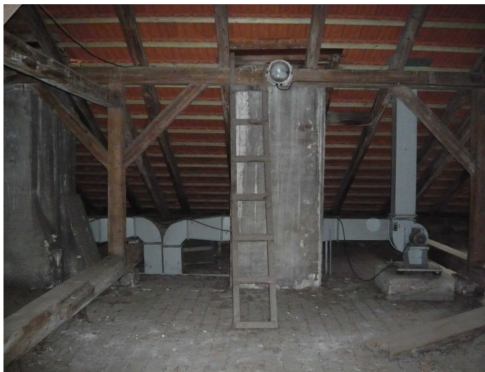
stávající stav vzt v půdním prostoru - dva odtahy od šaten u tělocvičny
